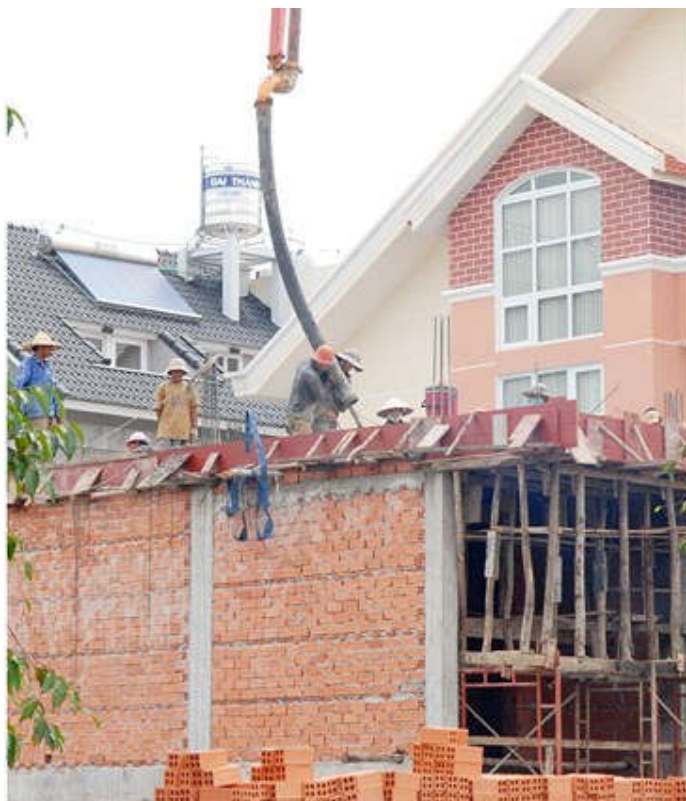
Xây nhà tại quận 2, TPHCM. Ảnh: Cao Thăng
